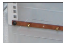
Barraje a tierra
